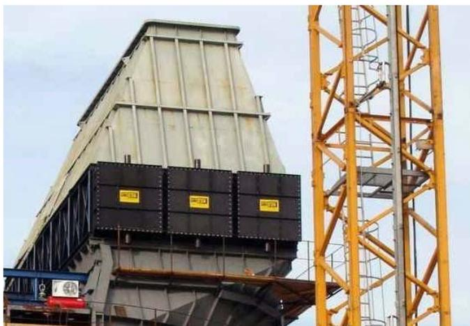
L'apparecchio ha un peso di 85 tonnellate, una potenzialità di 7.840 kW e una superficie di scambio totale di 5.990 m<sup>2</sup>.
