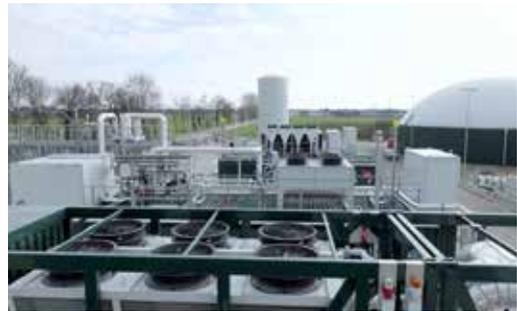
**Foto di AB Impianti - impianto di produzione di biometano con ventilatori ZAplus a servizio degli scambiatori di calore**
