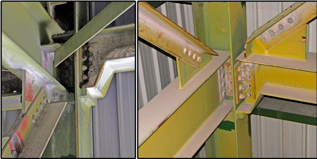
Figura 4.11: Particolare giunto trave-colonna
